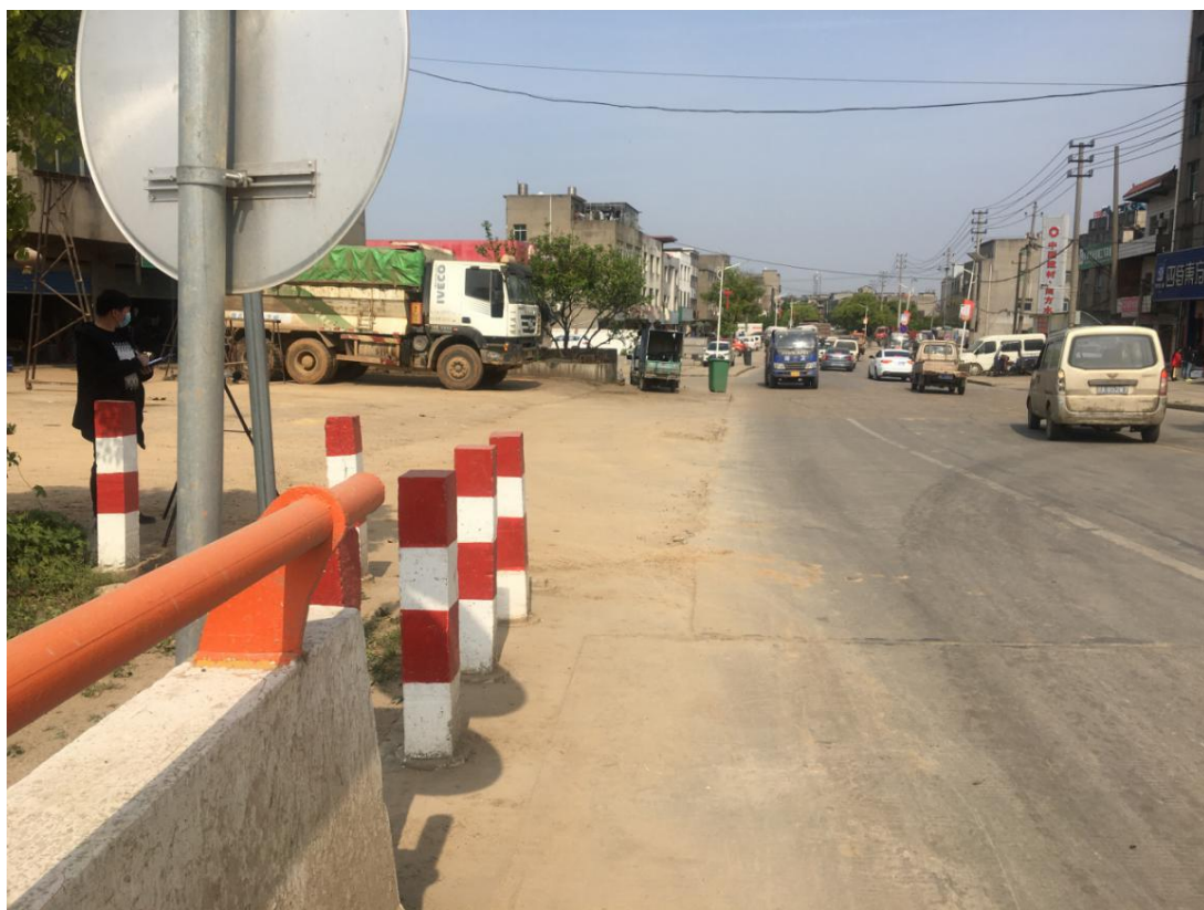
施工服务区（2020 年 2 月）
