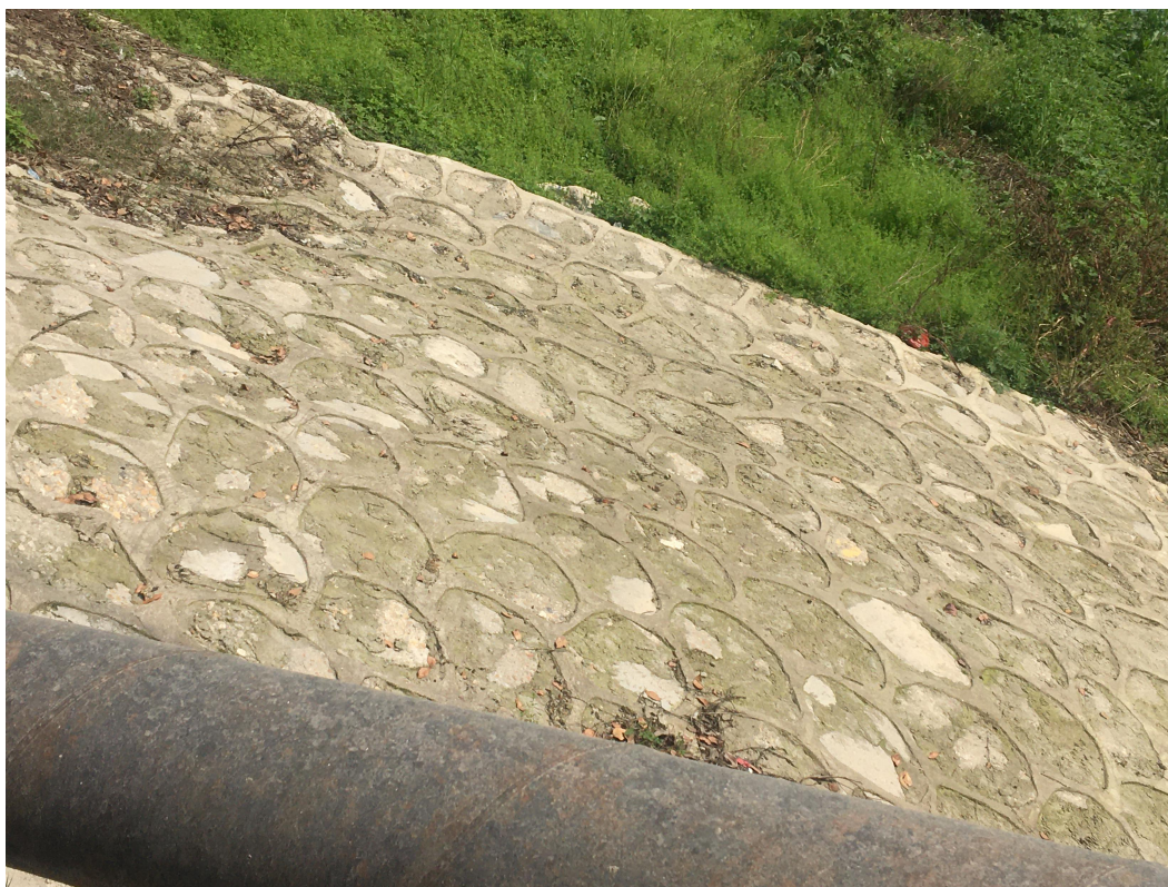
主体工程区（2020 年 2 月）
