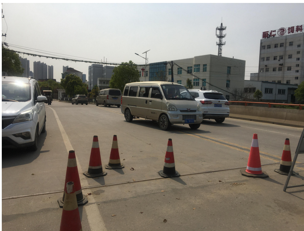
主体工程区（2020 年 2 月）
