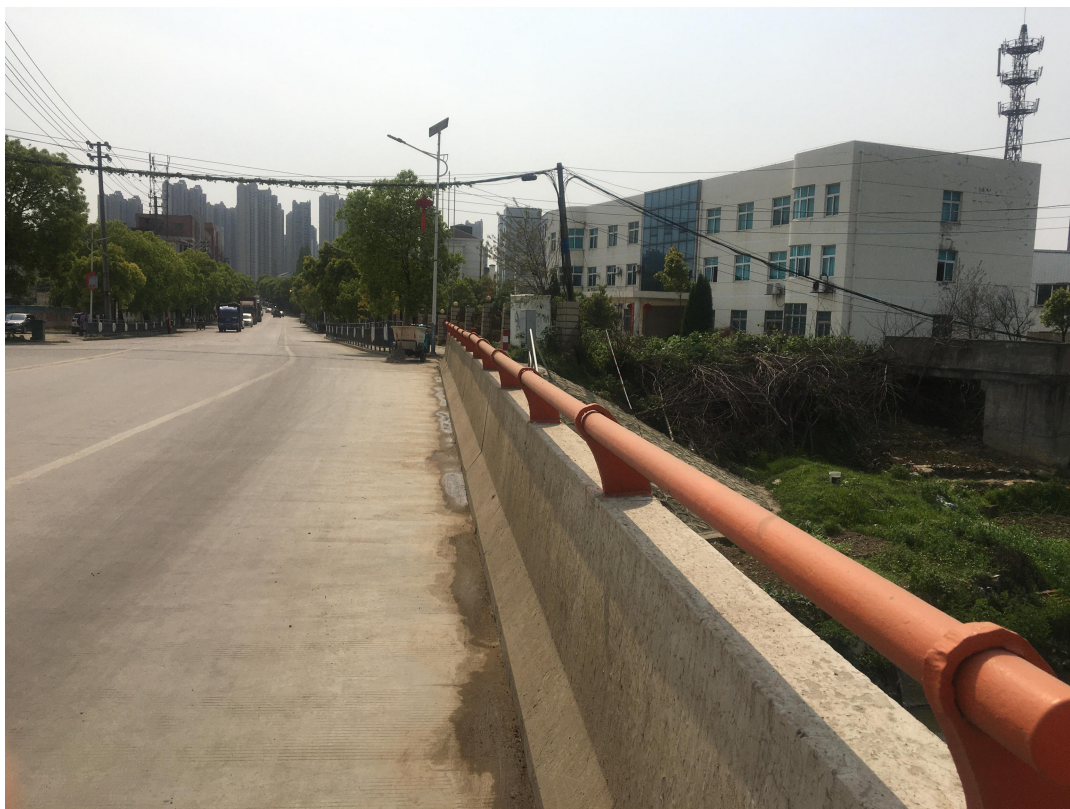
主体工程区（2020 年 2 月）
